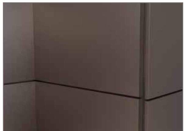
24 Finition d'angle avec un raccord
