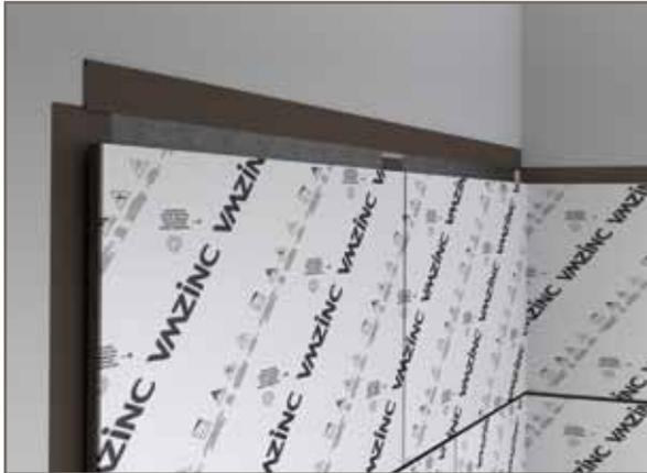
19 Finir le haut du mur par une plinthe haute VMZ Opus
