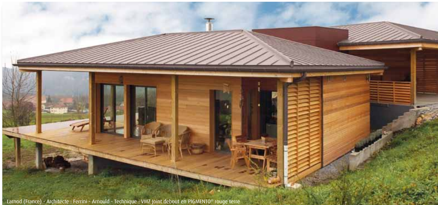
Larnod (France) - Architecte : Ferrini - Arnould - Technique : VMZ Joint debout en PIGMENTO® rouge terre
