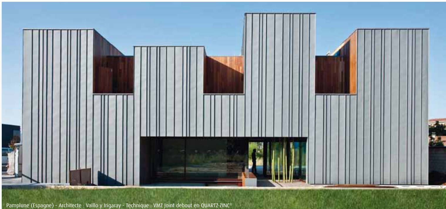
Pamplune (Espagne) - Architecte : Vaillo y Irigaray - Technique : VMZ Joint debout en QUARTZ-ZINC®
