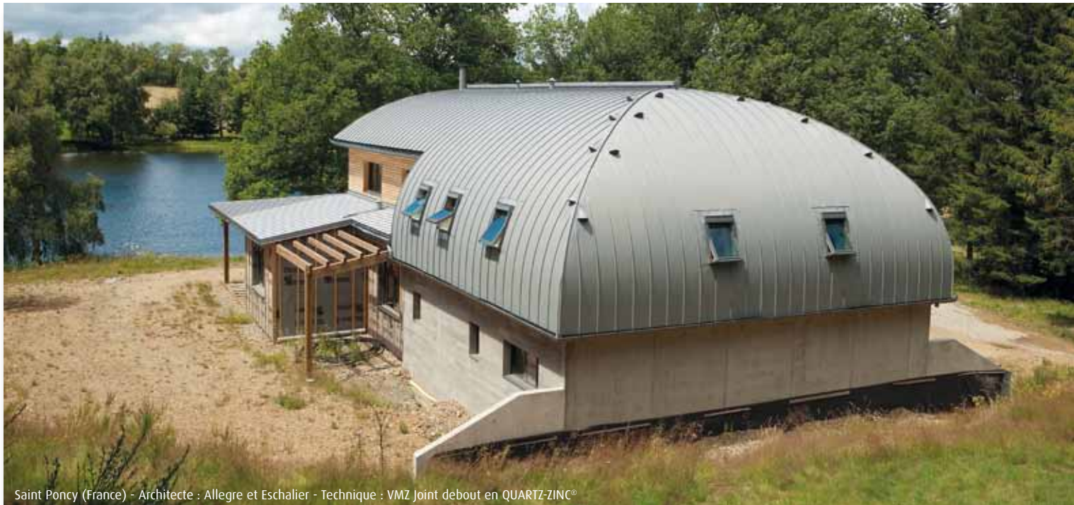
Saint Poncey (France) - Architecte : Allegre et Eschaliier - Technique : VMZ Joint debout en QUARTZ-ZINC®
